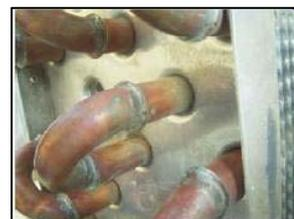
Überprüfen Sie gewissenhaft die Wasserdichtigkeit des Kreislaufes, bevor das Kühlmöbel in Betrieb gesetzt wird. Stellen Sie dafür fest, dass die Schraubenmutter der Düse des thermostatischen Ventils und die Mutter des Schrader-Ventils richtig angezogen sind.
